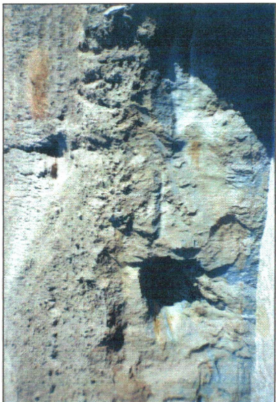
FOTO Nº 07 - Lençol freático no cut-off, antes do bombeamento.
