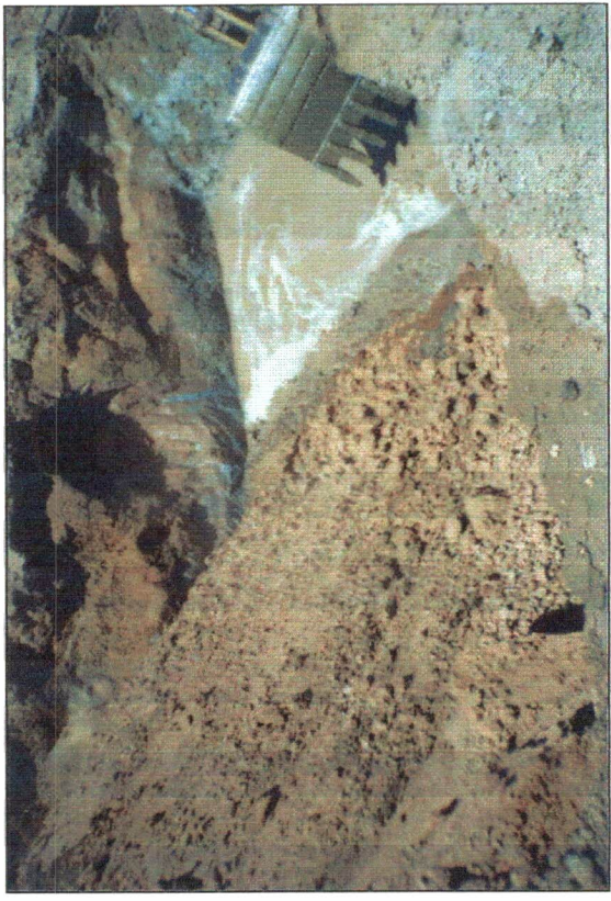
FOTO Nº 08 - Limpeza do cut-off (est. 47 à 45).
