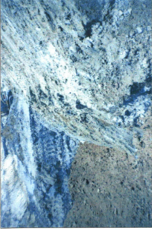
FOTO Nº 41 - Preenchimento cut-off, estaca 39.
