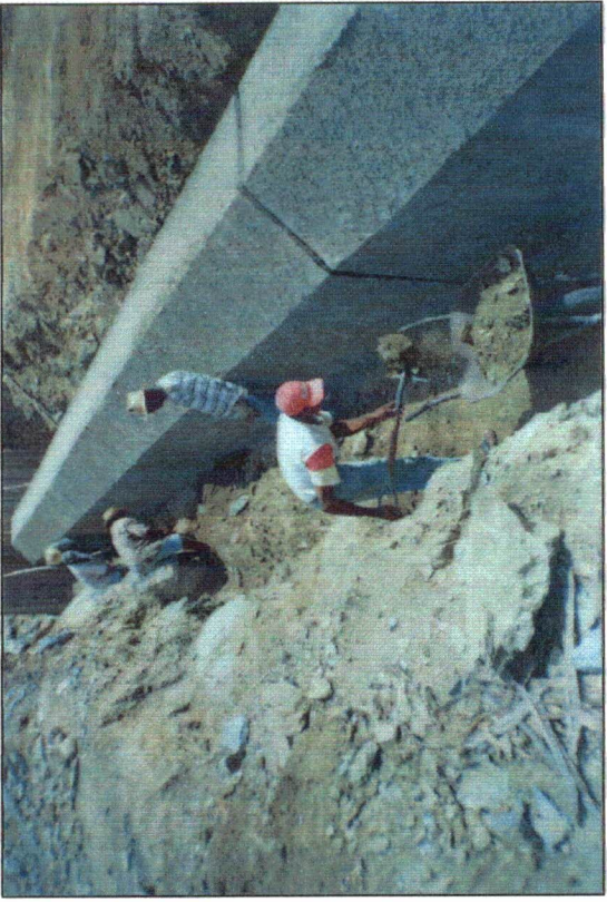
FOTO Nº 06 - Limpeza e regularização da galeria para o reator.
