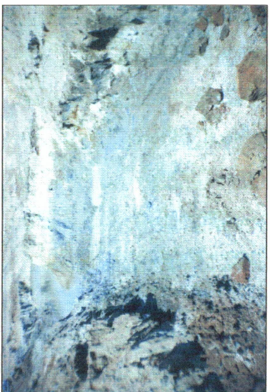
FOTO Nº 11 - Cut-off, parcialmente limpo e esgotado.
