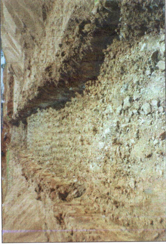
FOTO Nº 06 - Escavação da galeria da Tomada d'água.
